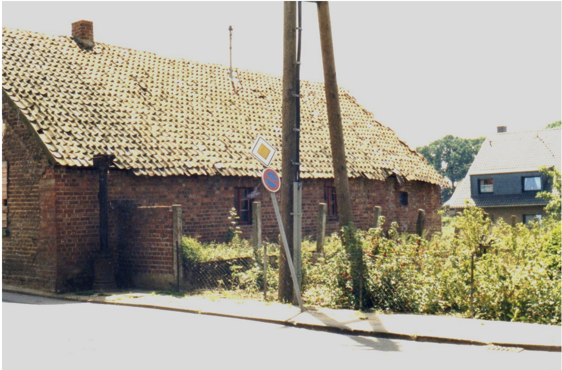
Die alte Pumpe an Kempkens Mühle
