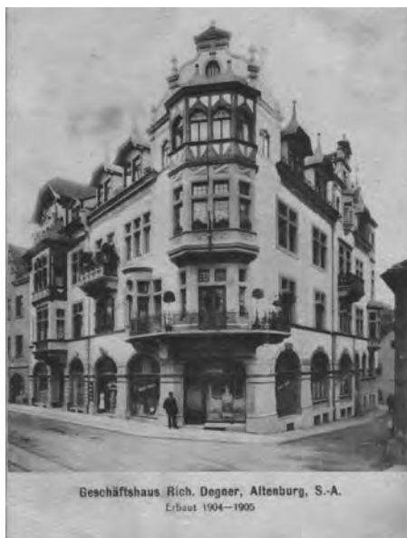
Brückchen 2 Eckhaus Brückchen/Wallstraße
